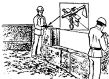
Установка маячных блоков и натягивание причалки
