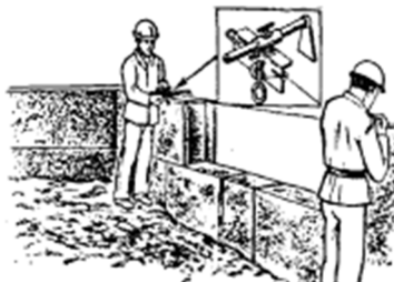
Установка маячных блоков и натягивание причалки
