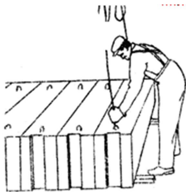
Строповка блока
