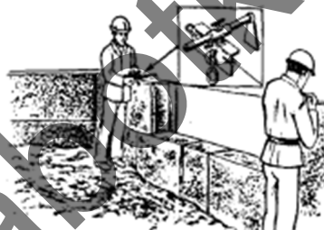
Установка маячных блоков и натягивание причалки
