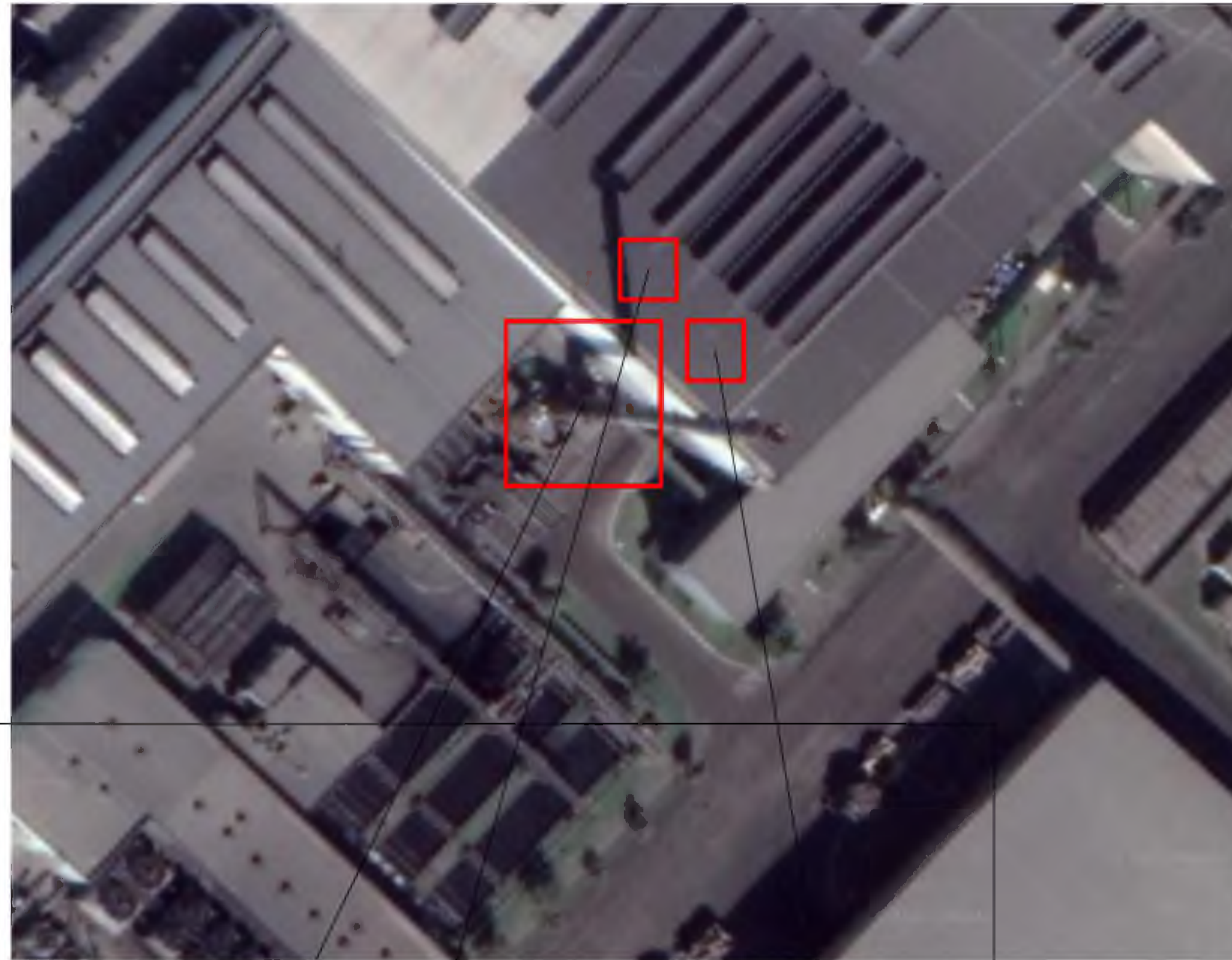
участок производства работ
