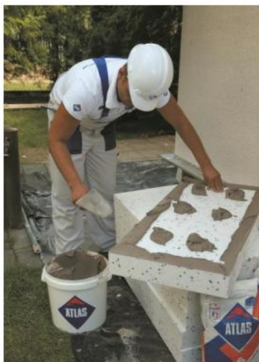
Рисунок 8 – Нанесение клеевого состава на теплоизоляционную плиту бортово-точечным методом
