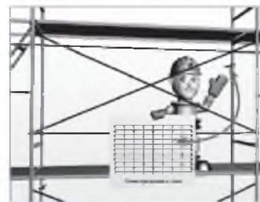
Фиксируйте леса к стене при помощи анкерных креплений в соответствии со схемой, приведенной в паспорте лесов
