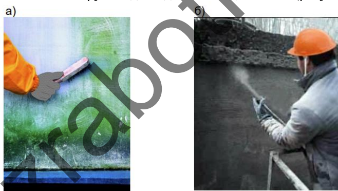
а - вручную с помощью металлической щетки; б - механизированным способом (водой)
