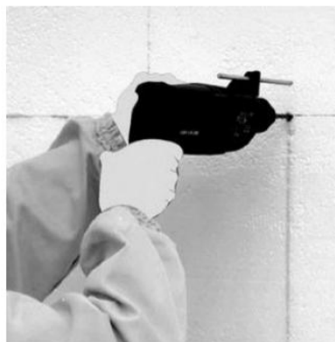
Рисунок 14 – Сверление отверстий электродрелью
