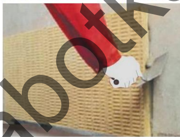
Рисунок 11 – Удаление лишнего клея
