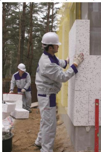
Рисунок 10 – Перевязка плит на углу здания
