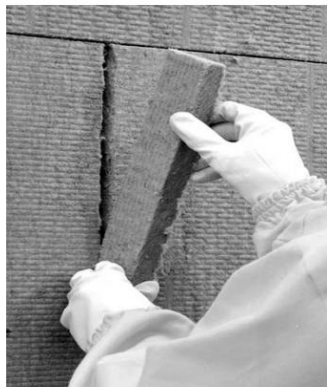
Рисунок 12 – Заделка щелей между теплоизоляционными плитами
