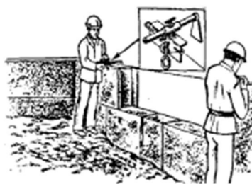
Установка маячных блоков и натягивание причалки
