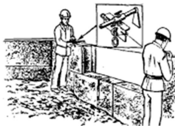
Установка маячных блоков и натягивание причалки
