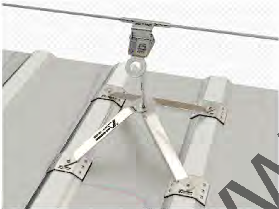
Общий вид крепления страховочных анкеров к стропилам
