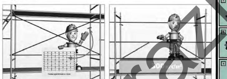
Фиксируйте леса к стене при помощи анкерных креплений в соответствии со схемой, приведённой в паспорте лесов
