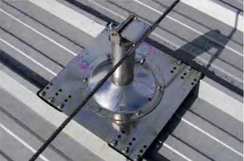
Допускается крепление привязей к несущим строительным конструкциям
