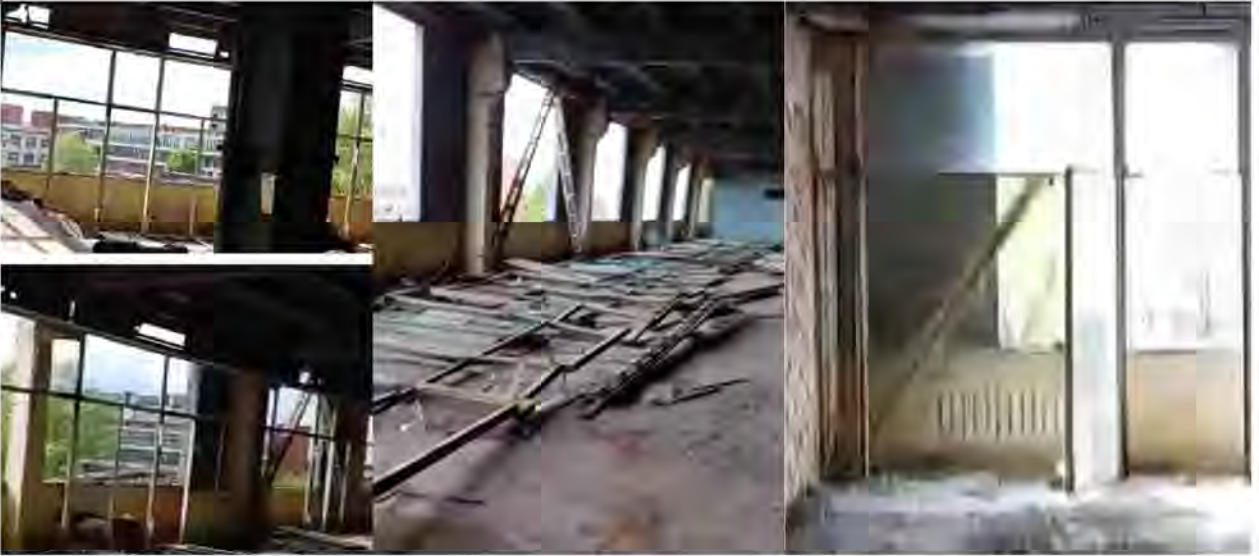
Фото демонтируемых элементов
