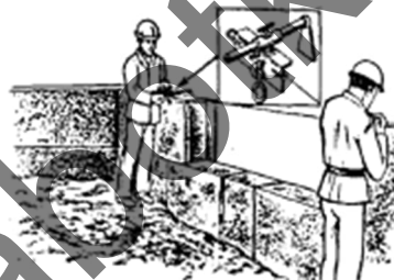
Установка маячных блоков и натягивание причалки
