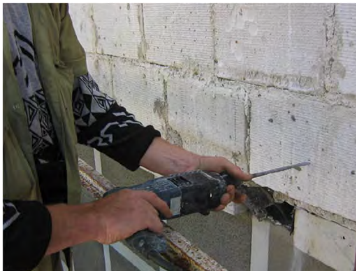
Рисунок 1. Сверление отверстий при помощи электродрели
