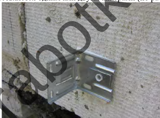
Рисунок 2. Крепление кронштейнов
