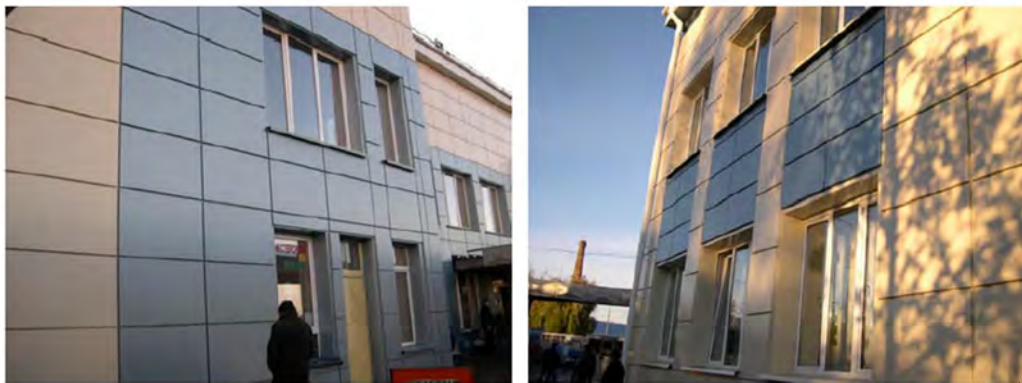
Рисунок 8, 9 Монтаж фасадных кассет МП 1005 (1000)
