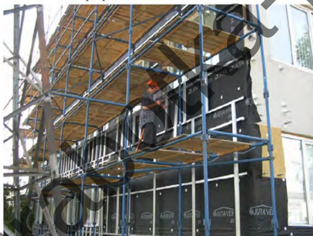
Рисунок 4. Монтаж каркаса
