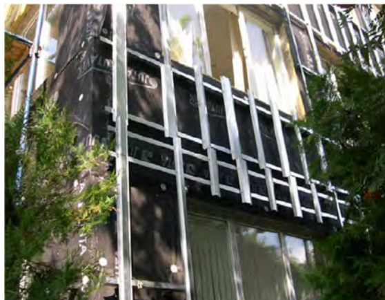
Рисунок 3. Монтаж каркаса
