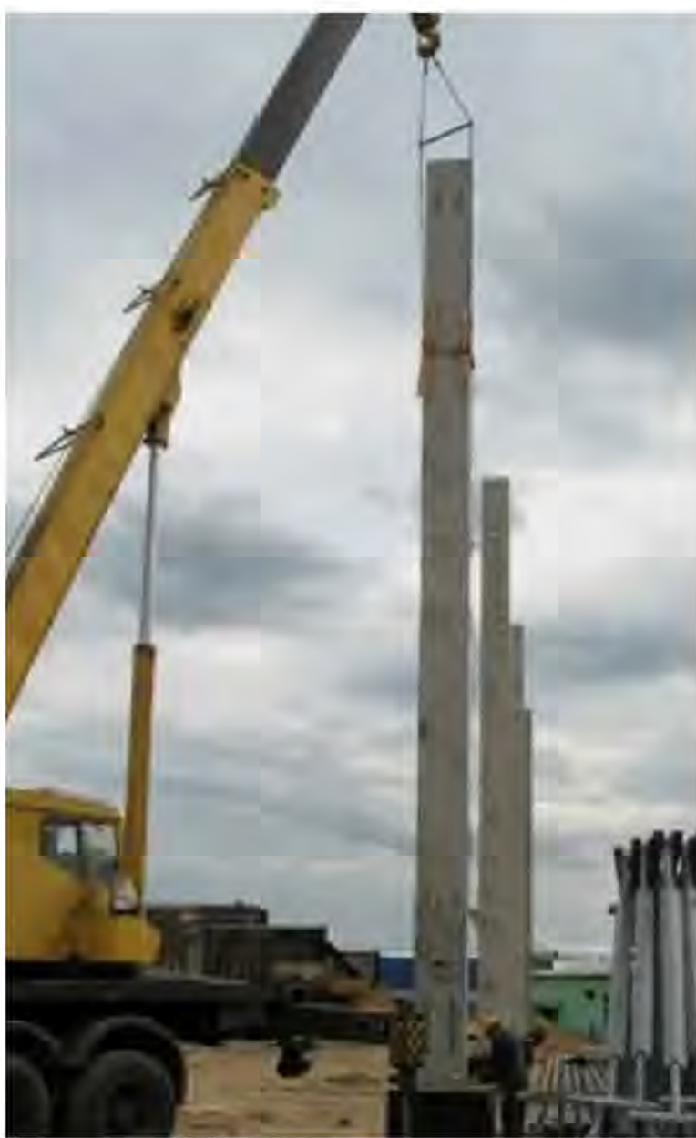
Схема монтажа колонны автокраном
