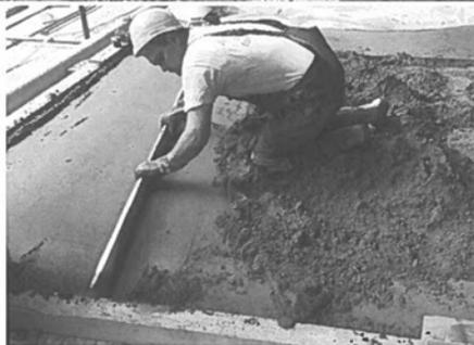
Рисунок 10 – Разравнивание смеси при помощи правила
