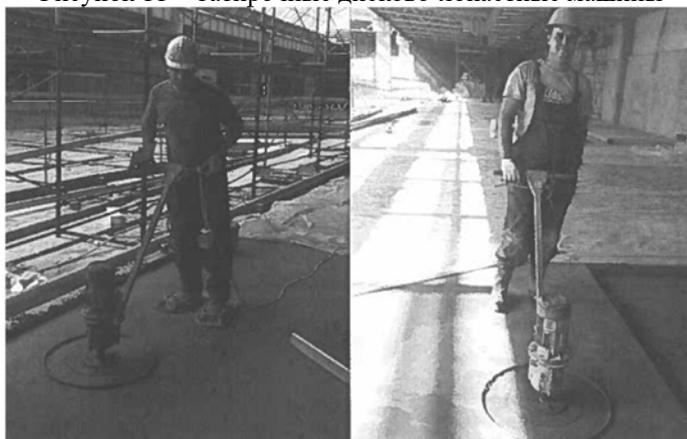
Рисунок 12 – Затирка поверхности свежееуложенной стяжки
