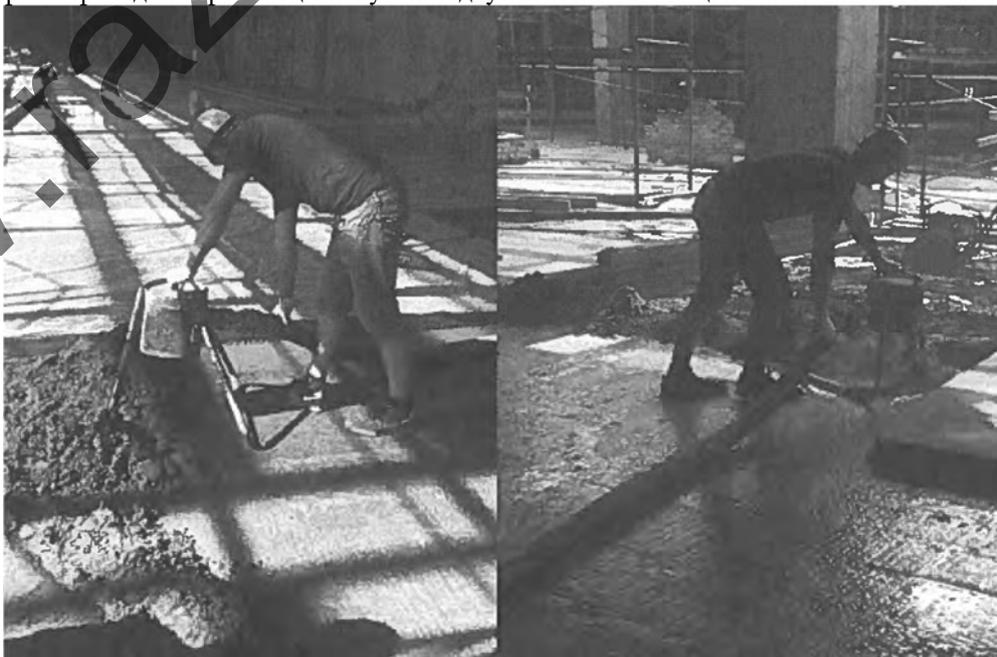
Рисунок 8 – подача и укладка смеси
