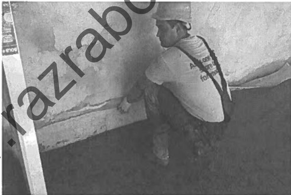
Рисунок 5 Укладка гидроизоляционного материала
