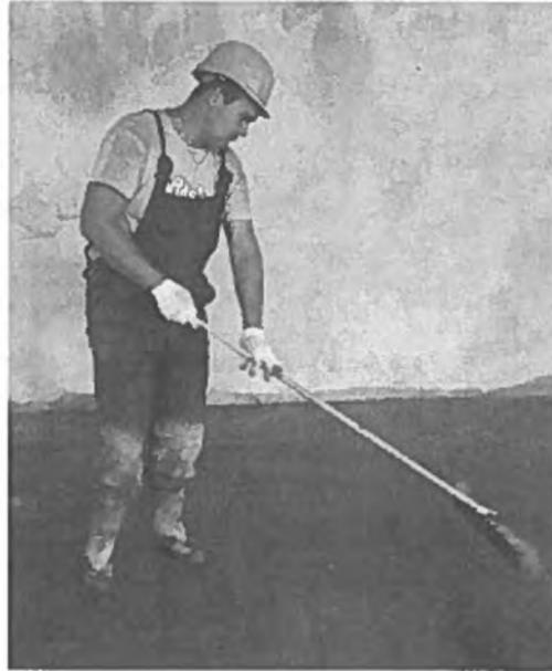
Рисунок 6 – Смачивание основания водой
